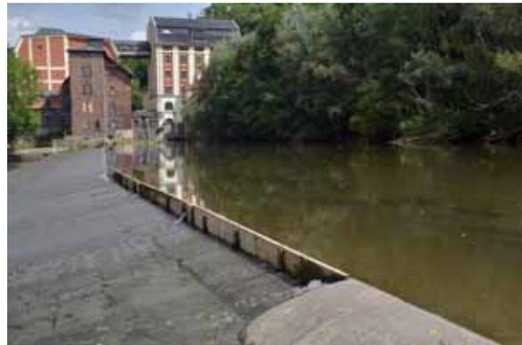
Abb. 13: Wehr an der Wasserkraftanlage in Camburg. Staustufen ohne ausreichende Fischwanderhilfen sind ein Grund für den schlechten Zustand der Fischfauna an der mittleren Saale.
